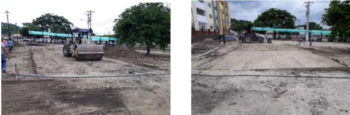
**Figura 0.2 Ejecución del cimiento del pavimento**
