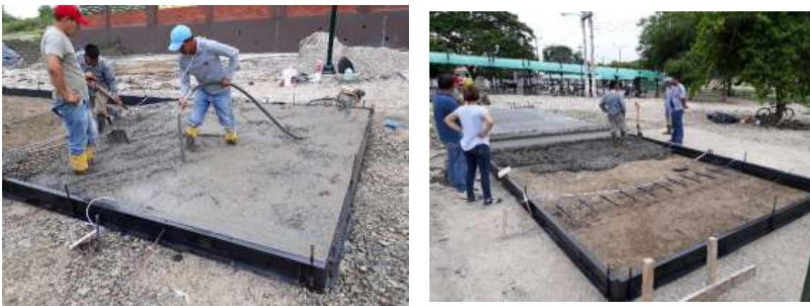
**Figura 2.4** Proceso de hormigonado de las losas
